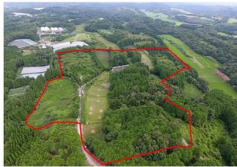
【着工前】（平成28年7月）
