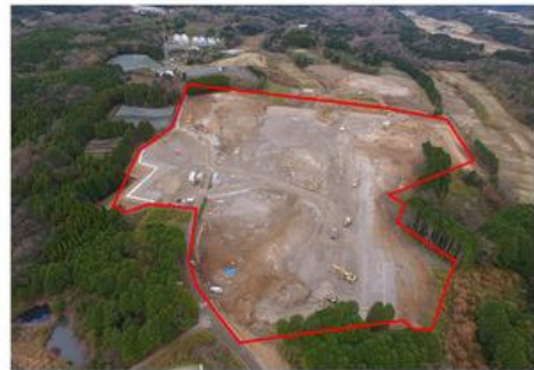
【施工中】（平成28年12月）
